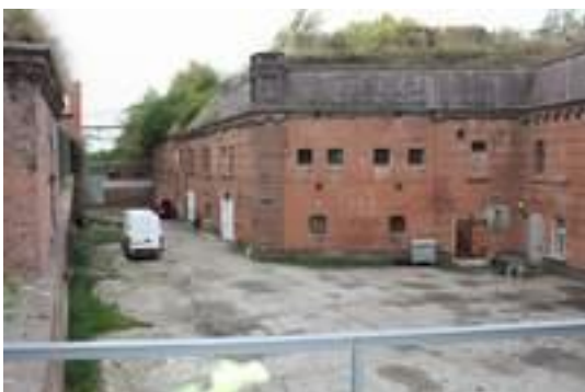
Das Festungsgelände -rechts
