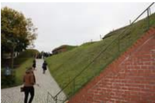
Zu den Wällen im Außengelände
