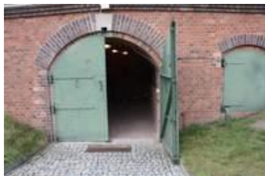
Munitionsdepots werden zur Gaskammer umfunktioniert
